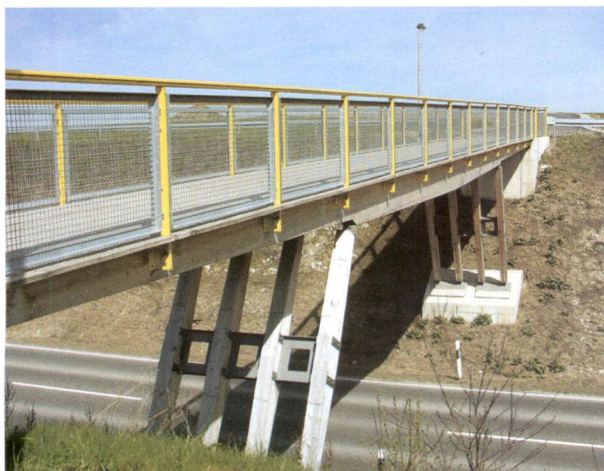
Bei der Rad- und Fußwegbrücke bei Crailsheim kommt Kerto-Q als frei bewitterte Fahrbahnplatte erfolgreich zum Einsatz.
