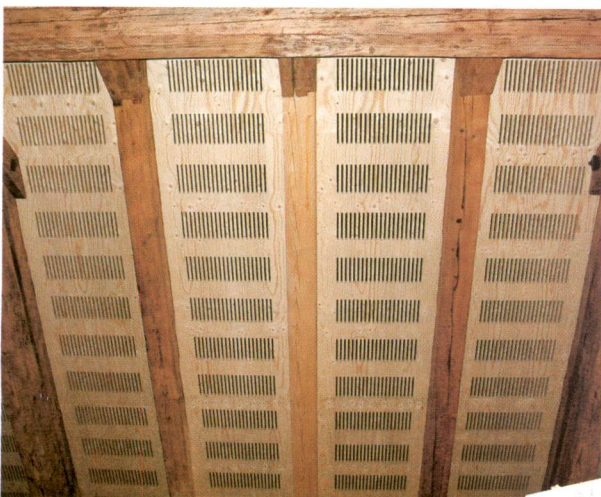
Geschlitzte – als Akustikpaneele ausgebildete – Kerto-Platten zwischen den Sparren bei einer Sanierung.
