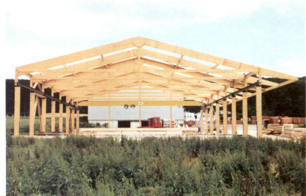
Kerto-Systemhalle mit Kranbahn und Satteldach in Lienen
