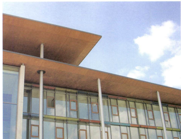
Große Auskragungen in zwei Richtungen, wie hier bei dieser schlanken Dachkonstruktion in München, machen sich die besonderen statischen Fähigkeiten von Kerto zunutze.
